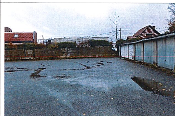
Au bout de la rue du Commandant Bayart, les garages et le mur de clôture du lotissement
